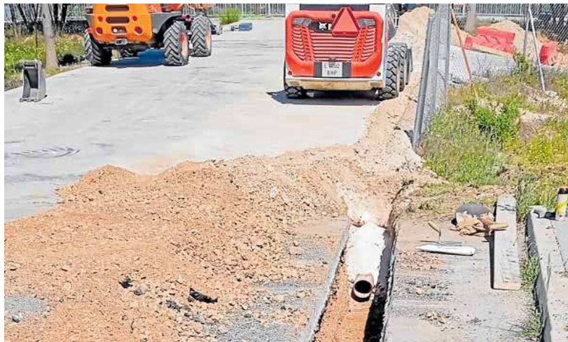
Comienzo de los trabajos de impulsión de las aguas residuales desde Peralta a Taralpe. sur
